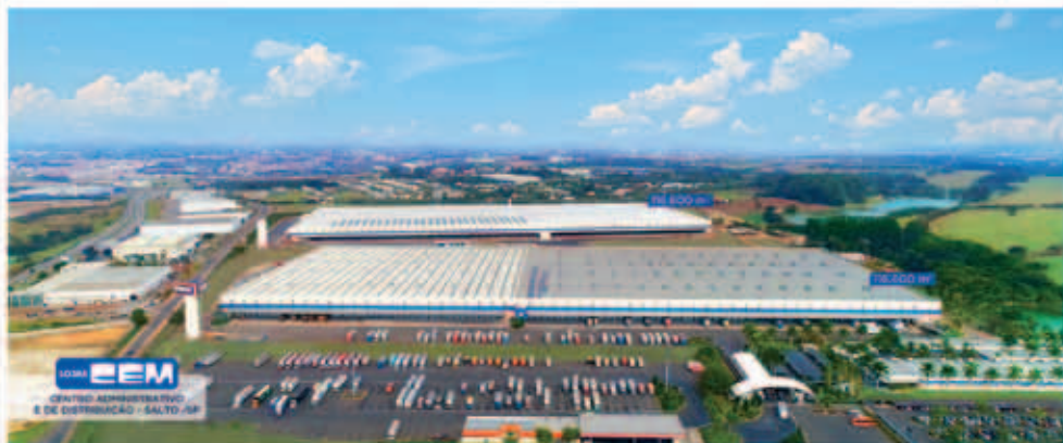
O Centro Administrativo e de Distribuição das Lojas CEM: dois depósitos com 116.600 m 2 cada um.
